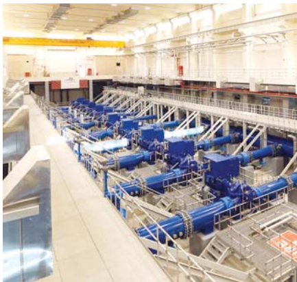
● جانب من مشروع الخزانات المعقدة بمنطقة الشامة
